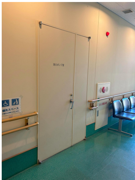
* 1階消火ポンプ室（放射線科前）
